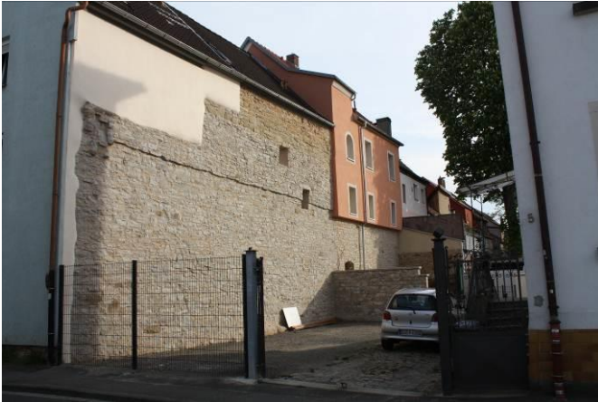
Sanierte nördliche Stadtmauer; Zustand 2017; bis ca. 0,7 m unter der Dachrinne Oberer Muschelkalk in Normalfazies, darüber Keuper-sandstein (ku)
