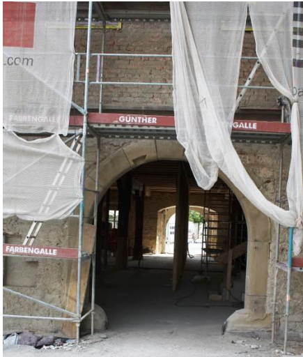
Zeughaus während der Restaurierung 2014: Detail des Ostgiebels
