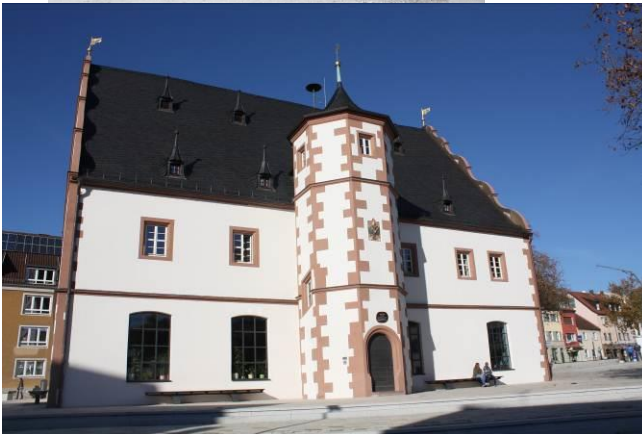
Saniertes Zeughaus (Südseite) – Zustand 2015
